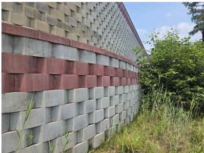
<옹벽 하부 상태양호>
