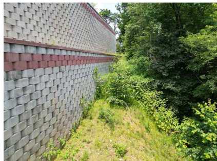
<옹벽 하부 전경>
