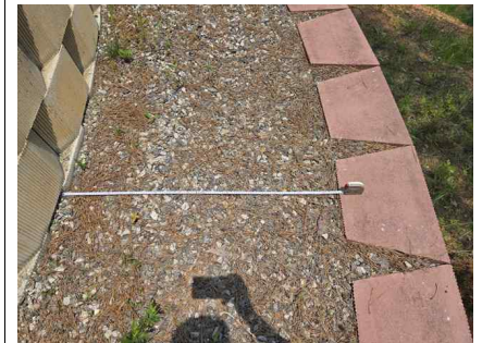
<소단 규격 상태양호>
