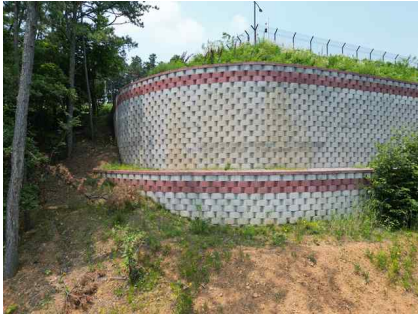
<옹벽 시점부 상태양호>
